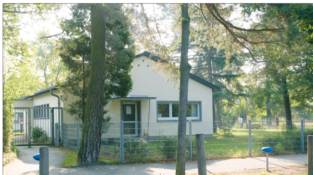
Im ehemaligen Hausmeisterhaus der Carlo-Mierendorff-Schule ist der Verwaltungsbereich der „Schule am Kiefernwäldchen“ untergebracht.
